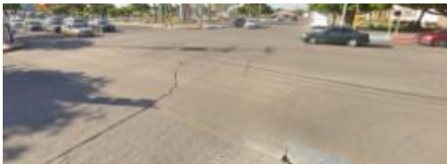
Figura 5. Calles del centro de Cd. Obregón sin cruces peatonales.
